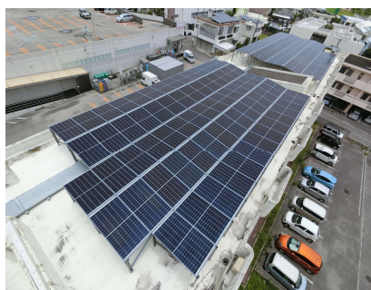
浦添ビル（データセンター）
