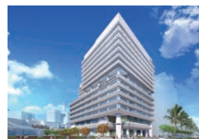
2025年に竣工予定の新本店ビル
